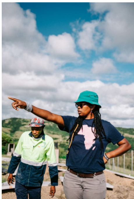
Sie weiss, wo es langgeht. Mercy Nqandeka betreut und leitet das WASH-Projekt in Bulungula. Hier besucht sie eine der Baustellen, auf der sanitäre Anlagen gebaut werden.
